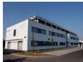
Budova C kanceláře, laboratoře, drobná výroba
