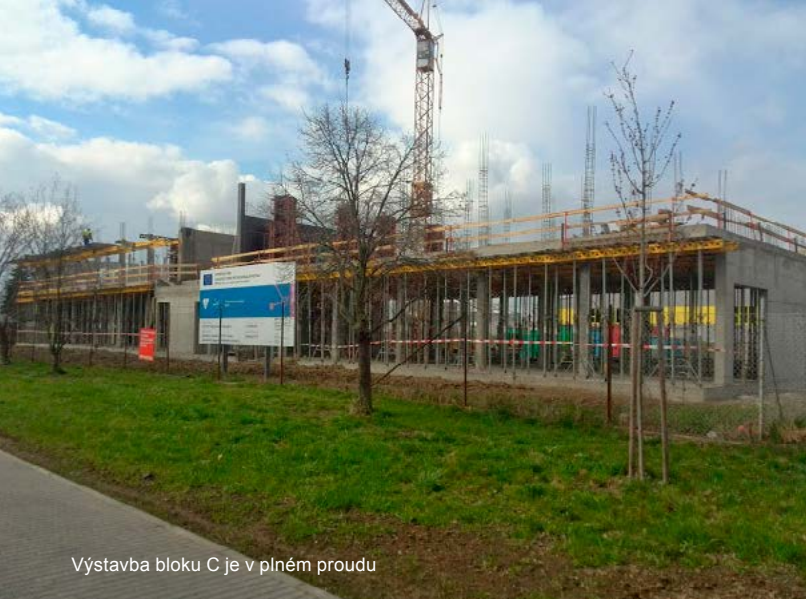
Byla zahájena výstavba bloku C
